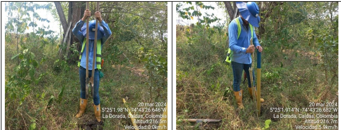
Fotografía 2. Instalación tubos de pvc para demarcación de parcela en área de rehabilitación
